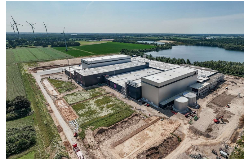
Baustelle in Goch, Stand 13.06.25
